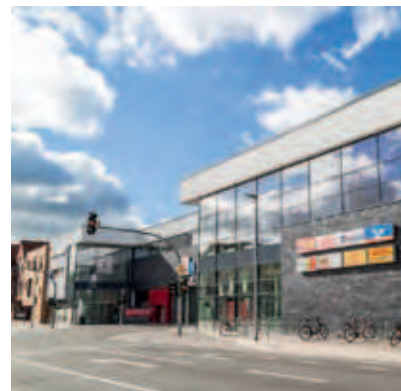
Fürth (OB IV): Das klassische Industriefloßhaus, ehemals Sitz der Quelle-IT-Abtei- lung, beherbergt inzwischen an- sprechende Büro- und Praxis- flächen.
